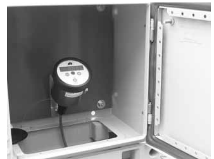
Bild 5: REDAS 4 für Batteriebetrieb mit Druckaufnehmer.
