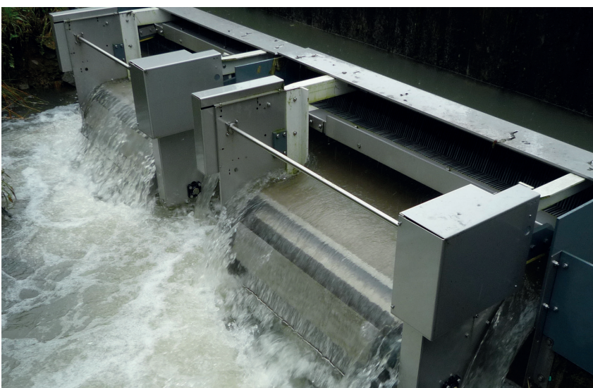
Bild 2: Zwei GiWa-Rechen-Module im Parallelbetrieb
