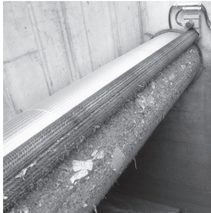
Bild 1: Trommeldrehfilter mit Filterkuchen nach Einstau ohne Abreinigung
