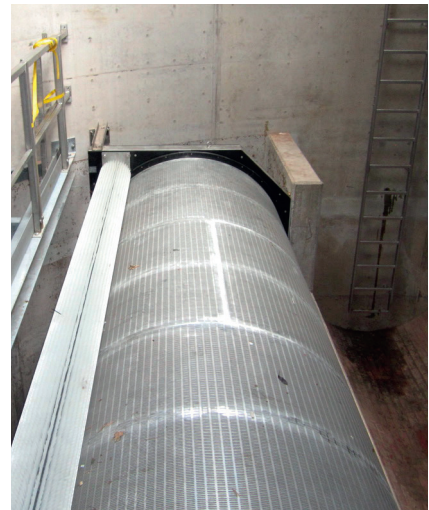
Bild 3: Querdurchströmte Siebtrommel mit 1,5 m Durchmesser und 6 m Länge an einem Beckenüberlauf. Ansicht von der Ablaufseite und von oben
