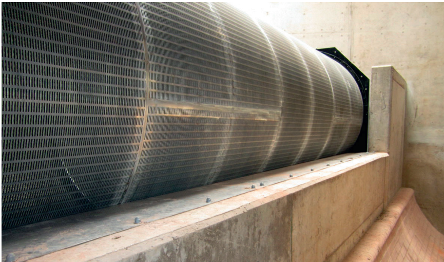
Bild 3: Querdurchströmte Siebtrommel mit 1,5 m Durchmesser und 6 m Länge an einem Beckenüberlauf. Ansicht von der Ablaufseite und von oben
