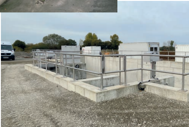
Oben: Das alte RÜB musste zuletzt sogar gestützt werden. Unten: Das neue, modern ausgestattete RÜB ist nun in Betrieb.
