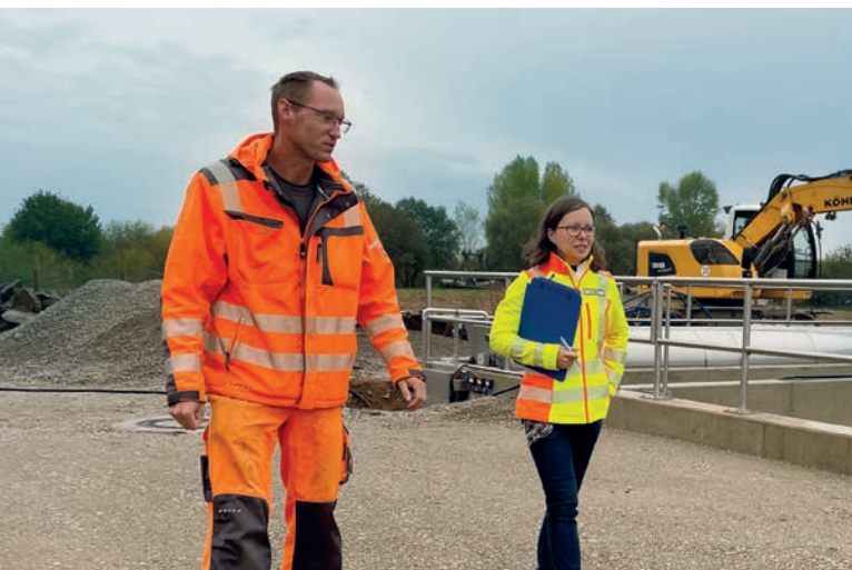
Bei der Inbetriebnahme eines neuen Regenüberlaufbeckens (RÜB): Julian Raum mit UFT-Mitarbeiterin Valerie Beck
