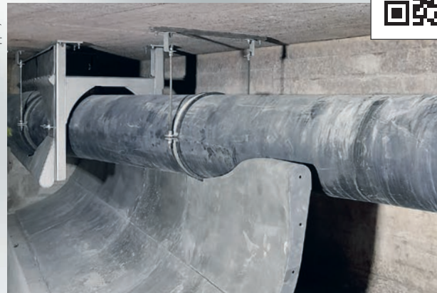
Teinacher Straße, Bauphase: Eine Mineralwasserleitung durchdringt die Schwellenkonstruktion
