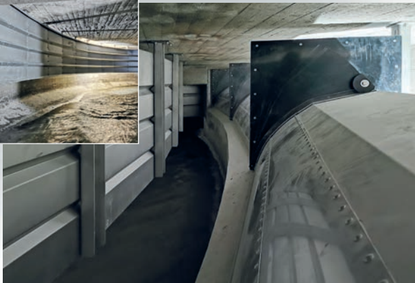
Hofener Straße, Bauphase: Tauchwand und Biegeklappen folgen der Bauwerks-Krümmung (Blick von innen)
