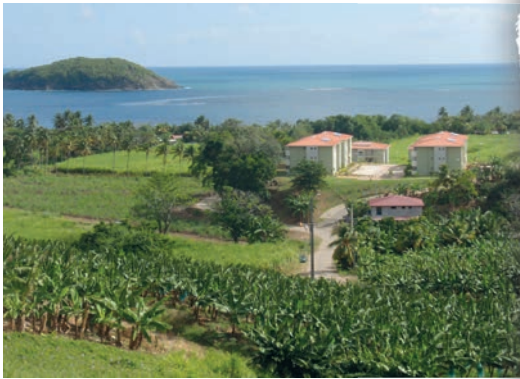
Aussicht auf Meer und Bananenplantagen von einer Baustelle auf Martinique
