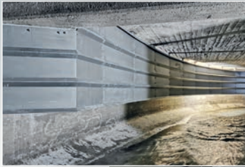
Hofener Straße, fertige Installation
