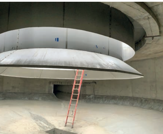
Wirbelabscheider von innen: Im Vergleich zur Leiter erkennt man die ungewöhnliche Größe
