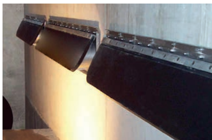
Schlitzklappen UFT-FluidSlot als Rückstausicherung an Entlastungsanlagen am Deutschen Eck
