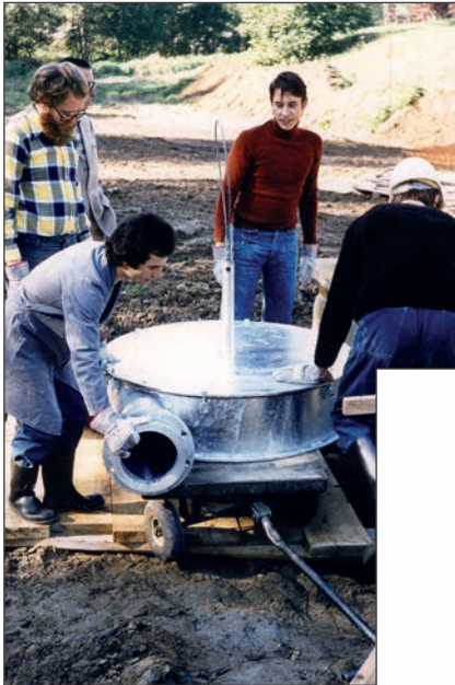
Eine der ersten Wirbeldrosseln wird vom Team der Uni Stuttgart eingebaut – glänzend und feuerverzinkt.
