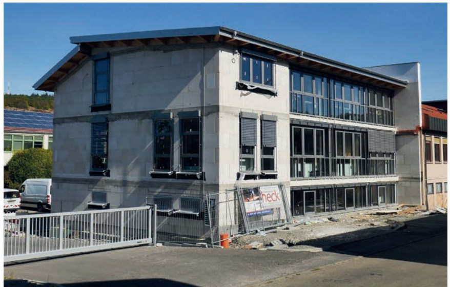
Der Anbau kurz vor der Fertigstellung – Entwurf und Bauleitung durch Architekturbüro Jochen Elsner aus Bad Mergentheim
