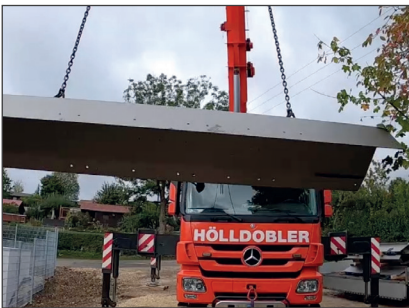
Wandwinkel als Unterkonstruktion
