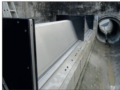
Federstauklappen, Blick zum Ablaufkanal
