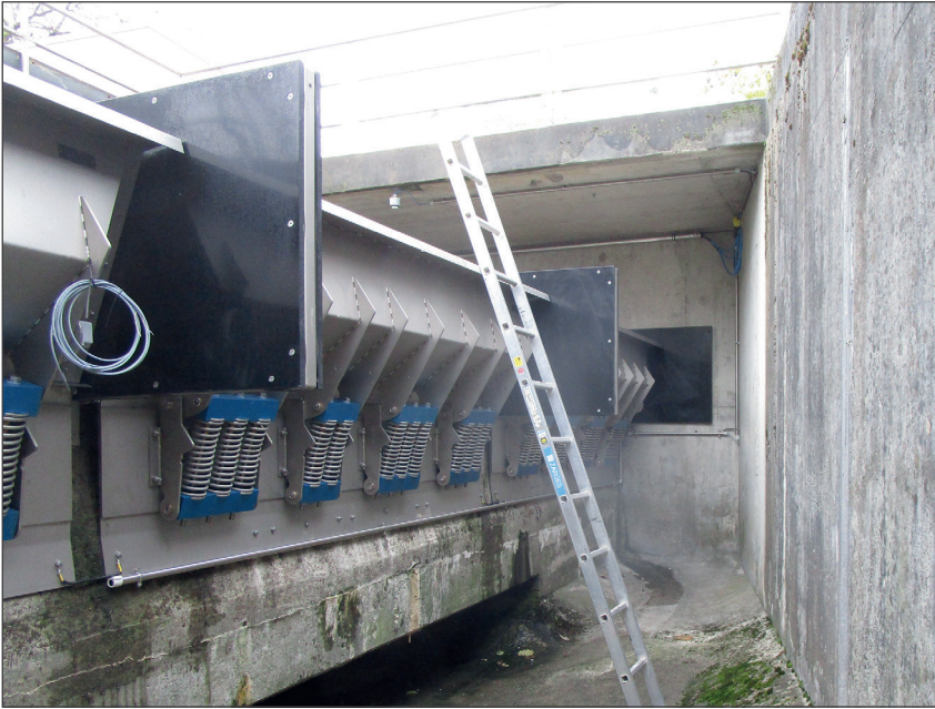
Federstauklappen von der Entlastungsseite
