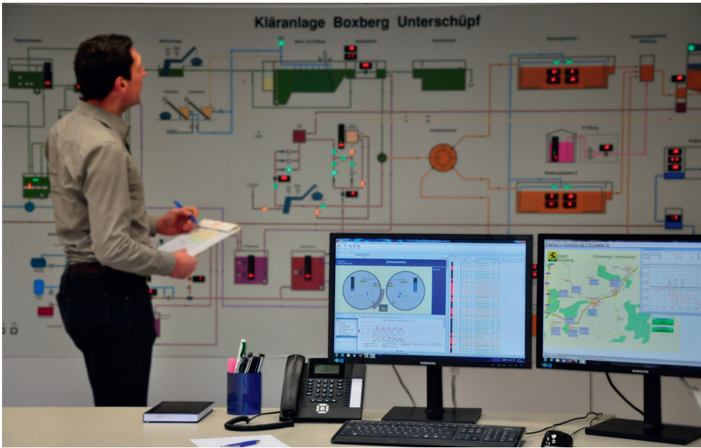
Bild links: Optimale Prozessvisualisierung durch den Einsatz eines Blindschaltbildes sowie eines Prozessleitsystems mit zwei Client-Arbeitsplätzen.
