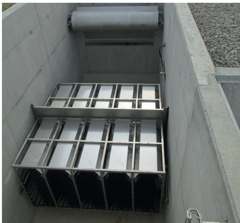
Blick in Fließrichtung in den Durchlaufteil mit den beiden Kreuzstrom-Schräglärermodulen. Hinten die Spülkippe und darunter der Selbstregulierende Klärüberlauf. Die Gitterroste zur Abdeckung des Durchlaufteils fehlen auf diesem Bild noch.
