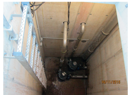
Bild oben: Zugangstreppe mit elektrischem Seilzug Bild Mitte: Betriebsgebäude für elektr. Steuerung Bild unten: Pumpenschacht
