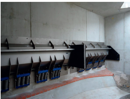
Bild: Federstauklappen 2 und 3 Blick von der Entlastungsseite
