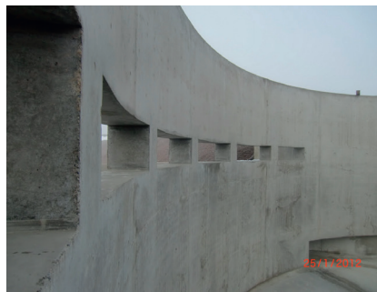
Bild: „Fenster“ im Rohbau für die Klärüberläufe
