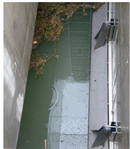
Bild oben: Spülkippe für die Beckenreinigung
