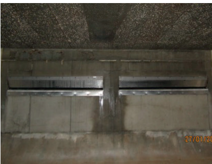
Bild: Selbstregulierende Klärüberläufe Ansicht in Fließrichtung
