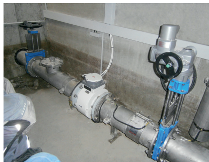
Bild: MID-Anlage kurz nach der Montage
